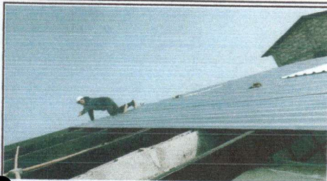
Foto 1: Sustitución de láminas troquelada aluzinc calibre 26
