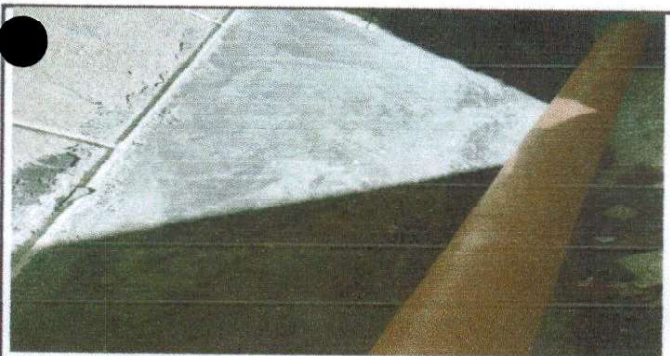
Foto 5: Mejoramiento con repello al muro
